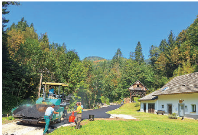
Asfaltiranje ceste v Jazbecovi grapi
