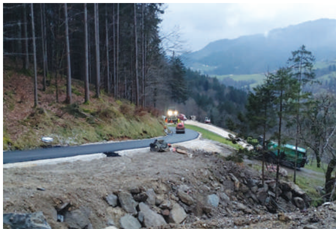
Asfaltiranje ceste v Delnice, odcep Štantman
